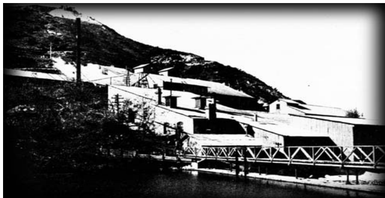
Budynki infrastruktury kopalni złota z 1897 r. 84
