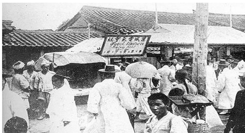
Pierwsza siedziba powstałej w 1898 r. firmy Seoul Electric Corporation 96 .
